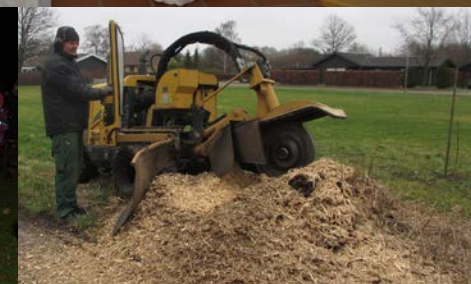
Stubrydning på Brandsmosevej
